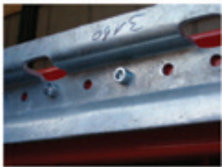
Figura 11: barra di ancoraggio
