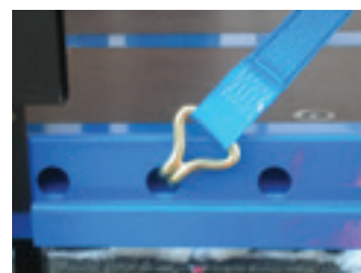
Figura 13: foro di ancoraggio nel profilo laterale
