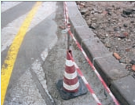
Situazione non regolare, il ferro sporgenti dal cono non è protetto
