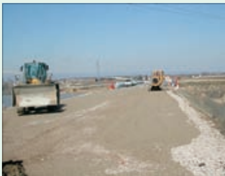
Esempio di mezzi d'opera semoventi in cantiere
