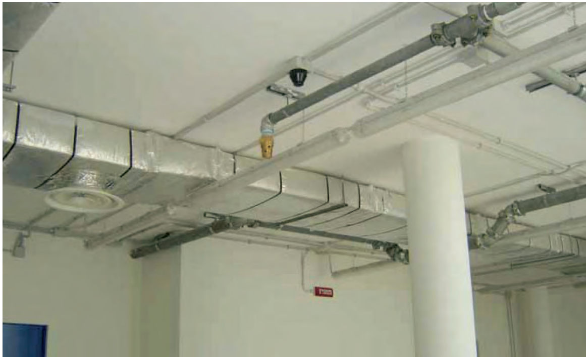
SISTEMA DI SPEGNIMENTO A SATURAZIONE TOTALE
